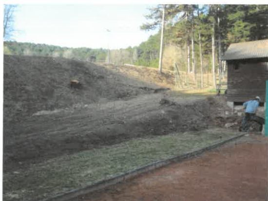
Anlegung der Rampe 2010
